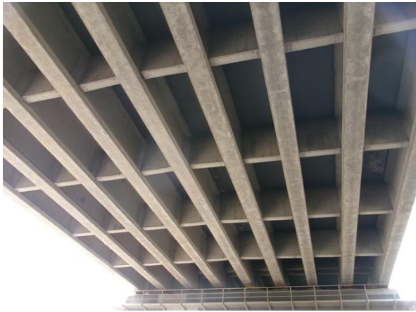
바닥판 하면 및 거더 전경
